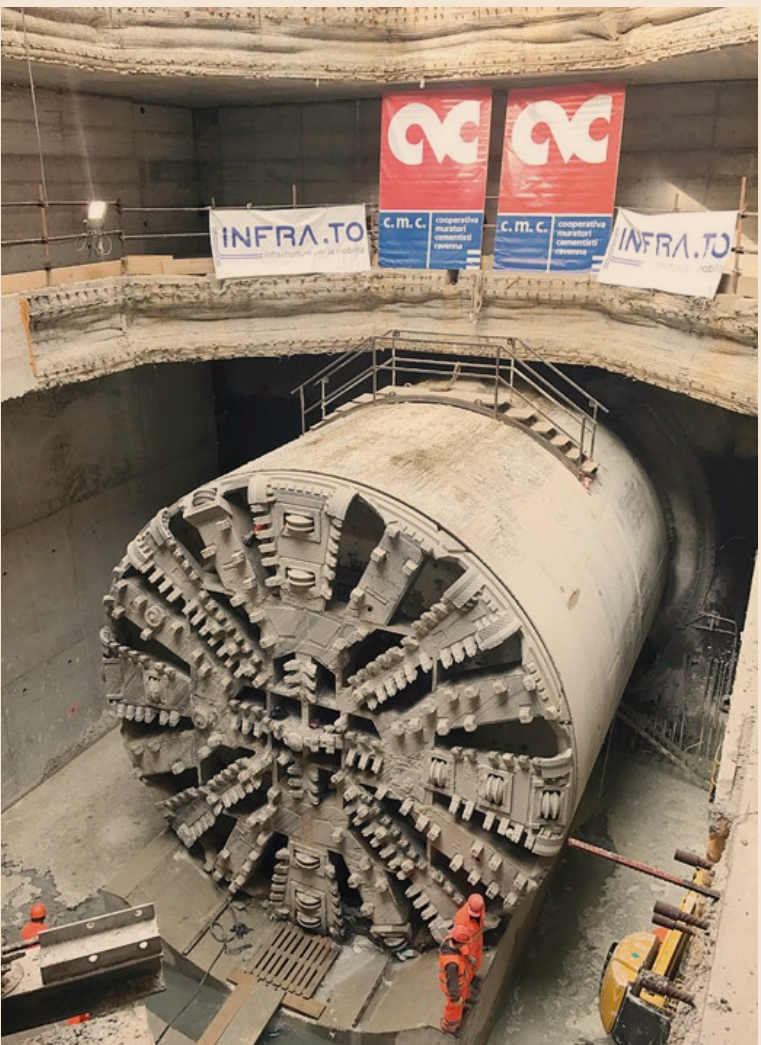
Tunnel boring machine. Una Tbm di Cooperativa Muratori e Cementisti: è una macchina escavatrice ad alto contenuto tecnologico
