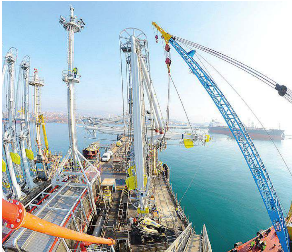
I lavori di revisione dei bracci di discarica
