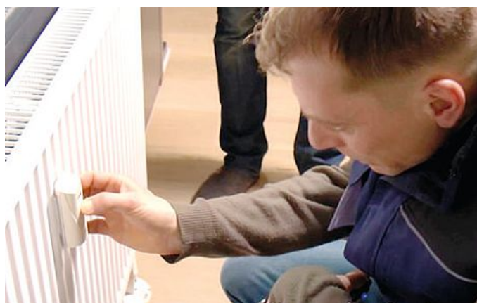
L'installazione di un contabilizzatore di calore
