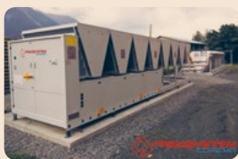
Impianto di raffreddamento con free cooling per linea di estrusione cast: massimo rendimento e risparmio energetico
