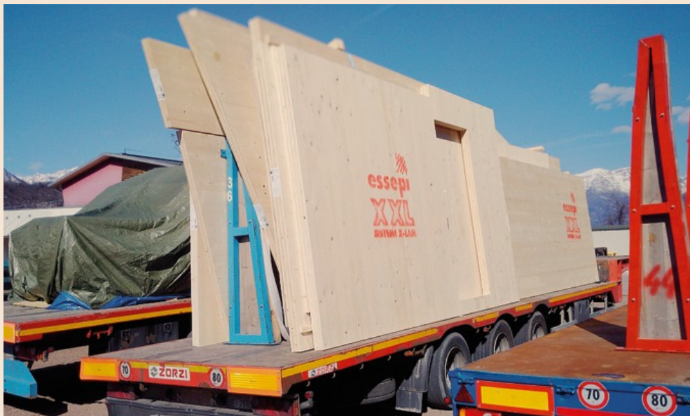
Hi-tech. Pannelli realizzati con il sistema X-Lam per le costruzioni in legno
