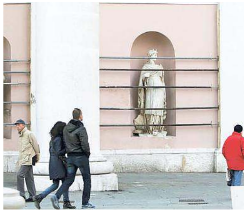
I puntelli sono stati messi dopo il sisma di ottobre
