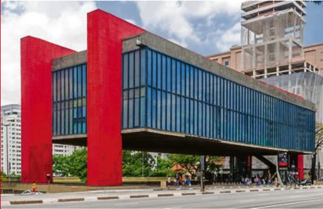
Conçu par Lina Bo Bardi en 1968, sa structure en béton, métal et verre semble comme suspendue à deux énormes portiques rouges. Photo The Photographer/CCO
